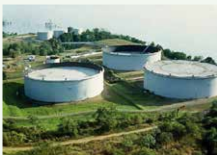
Tanques con membrana flotante
