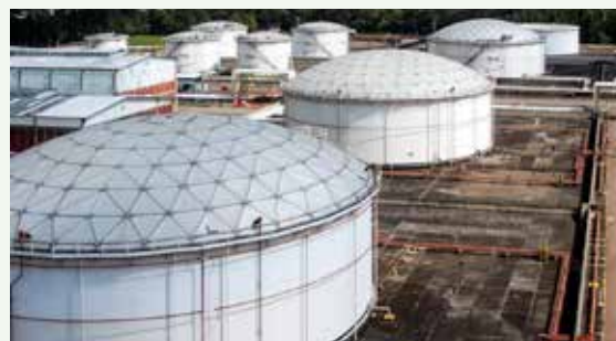
Tanque con Membrana flotante y techo geodésico
